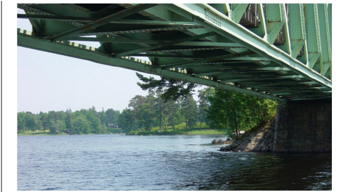
Blick von der früheren Eisenbahnbrücke auf Piksborg.
